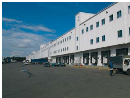
Терминал, склады (г. Пушкино)
